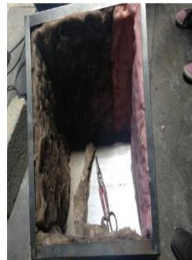
*Figura 1.4 se realiza el corte del aislante para ser colocado.*
