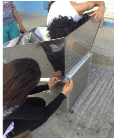
*Figura 1.7 Se implementa bisagras en la base del reflector.*
